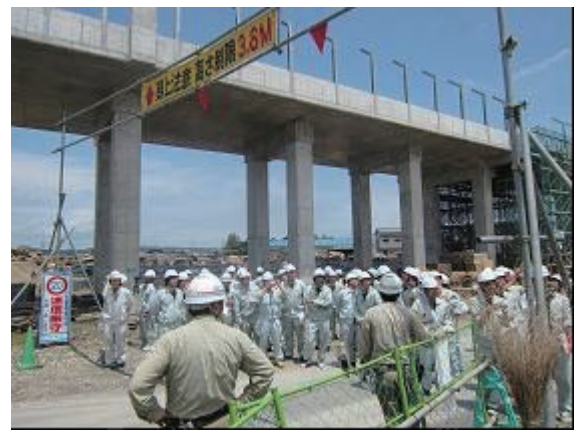
写真 7-4 ものづくり（橋の建設）の現場視察
