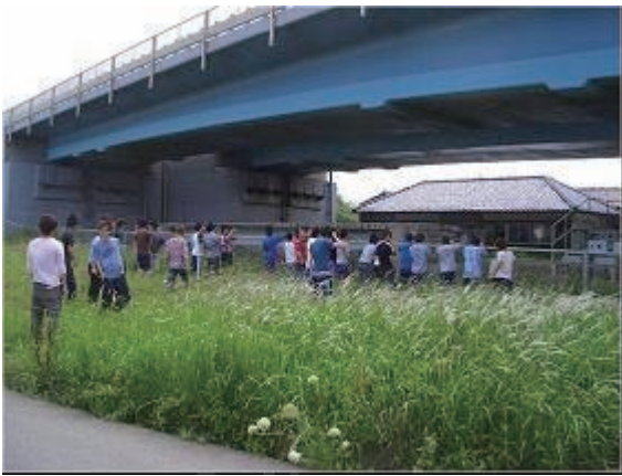
写真 7-3 劣化したコンクリート橋の現地観察
